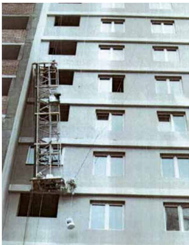
Рис. 38. Групповой несчастный случай при эксплуатации фасадного подъемника ZPL630
