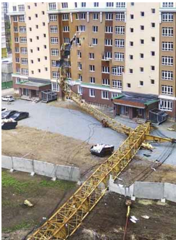
Рис. 50. Падение башенного крана КБ-408.21-02 в результате сильного порыва ветра в г. Кемерово
